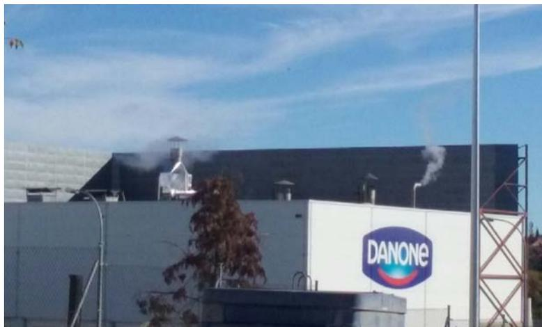
Figura 31. Detalle del sistema de evacuación insuficiente de DAN
